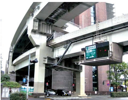
第 7 図 環 4060 上層：特殊な支承支持補強 Fig. 7 Upper portion of Pier C4060 : Special support reinforcement
