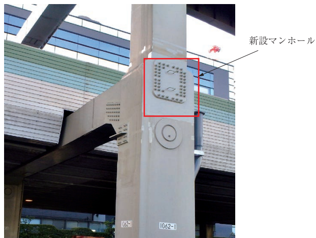
第10図 新設マンホール Fig. 10 New manhole
