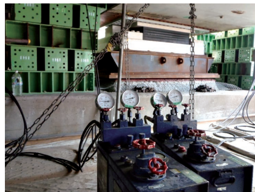
第 16 図 中間支点上での支承取替え
