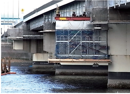
(a) 足場設置
