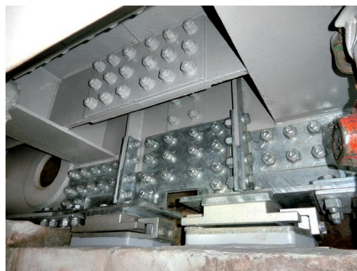
第28図 支承取替え後の様子（神田川護岸側） Fig. 28 After replacement of bridge support
