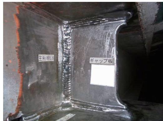
第 25 図 ウェブギャップ板取替え前後の様子 Fig. 25 Before and after replacement of web-gap plate
