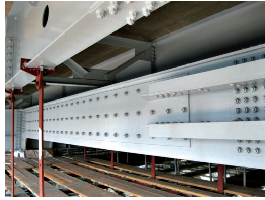
第 19 図 当て板補強の状況 Fig. 19 Reinforcement plate
