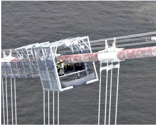
第 23 図 移動防護台車 Fig. 23 Movable protection device
