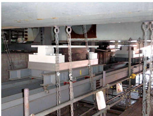
第 16 図 中間支点上での支承取替え
