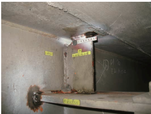
第 25 図 ウェブギャップ板取替え前後の様子 Fig. 25 Before and after replacement of web-gap plate
