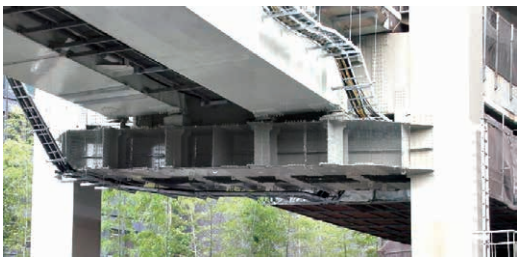
第 3 図 環 4060 下層：増設横梁・箱桁フルウェーブ化
