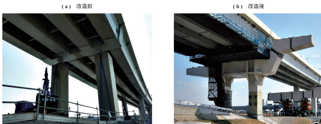
第 32 図 小松川 JCT 河川部工事 P82 橋脚ラーメン橋脚化 (6) Fig. 32 Reconstruction of Bridge Pier 82 at Komatsugawa junction (6)
