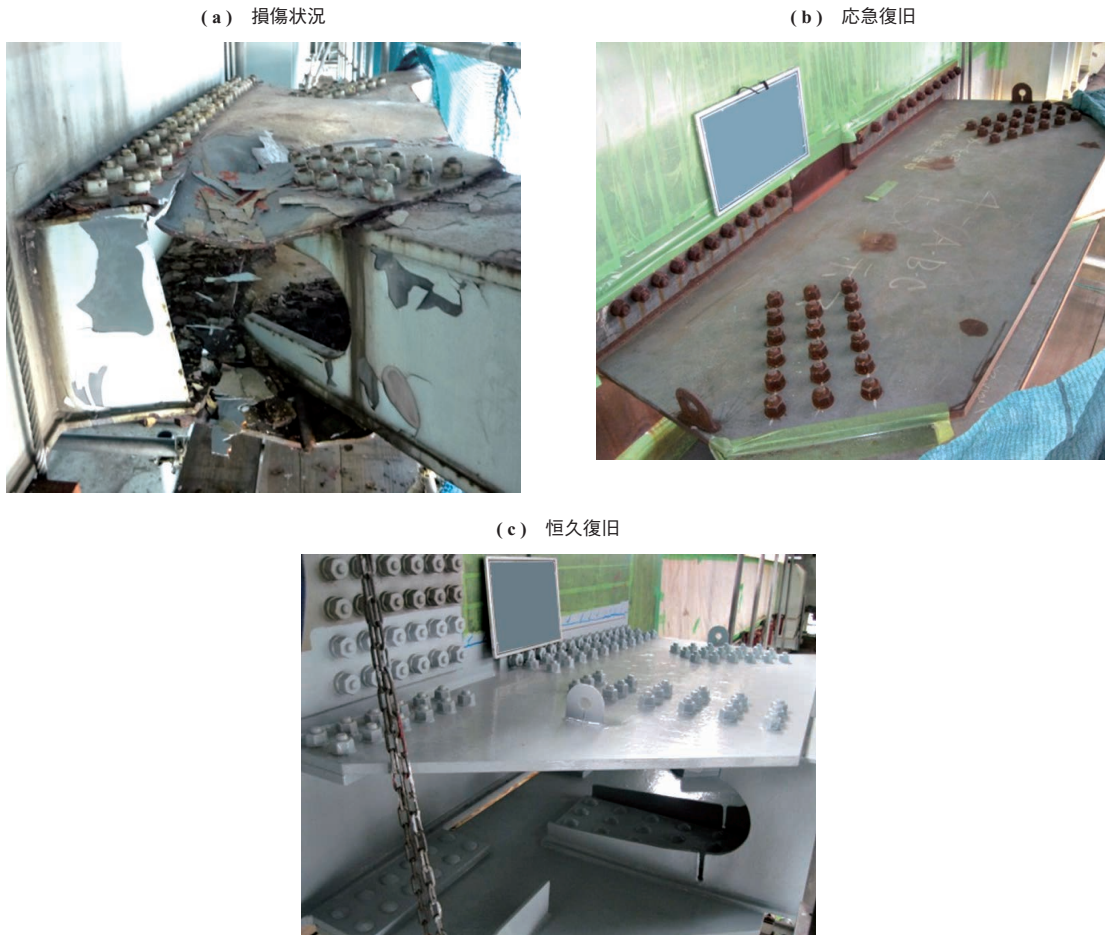
第 21 図 ガセット復旧工 Fig. 21 Restoration of gusset plate
