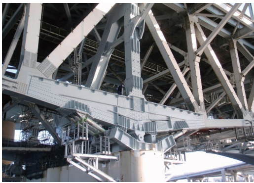
第 20 図 支点部補強の状況 Fig. 20 Reinforcement at bridge support
