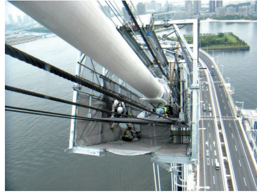
第 23 図 移動防護台車 Fig. 23 Movable protection device
