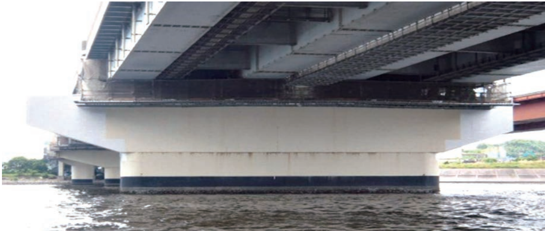
第 17 図 湾 1516 橋脚の横梁拡幅 Fig. 17 Additional concrete beam at Pier B1516
