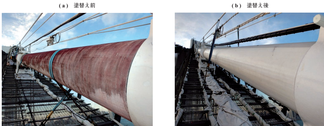
第 22 図 塗装塗替え前後の様子 Fig. 22 Before and after re-painting
