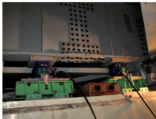
第 14 図 ジャッキアップ工法
