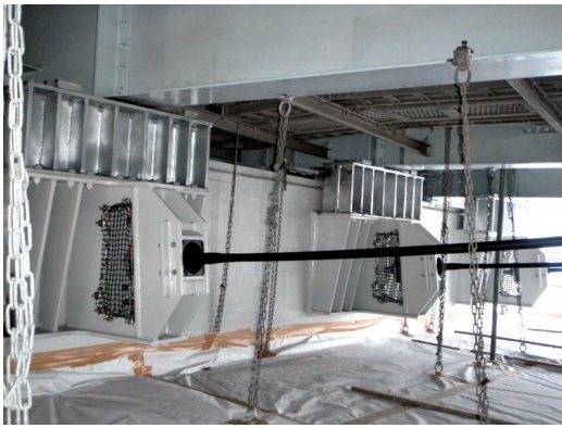
第 15 図 落橋防止と段差防止構造
