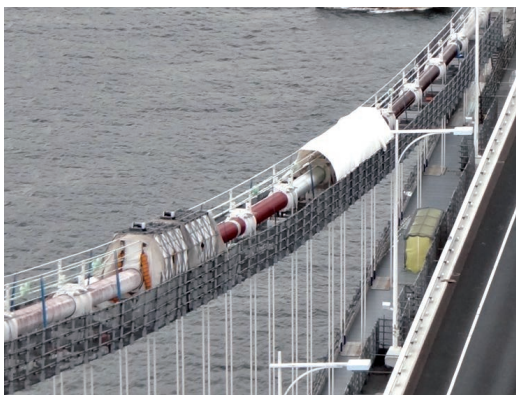
第 24 図 飛散防止設備と作業状況 Fig. 24 Work status for dispersal prevention equipment
