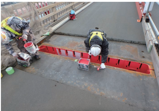
第 7 図 鋼床版ブロック端部の塗替え塗装の作業状況 Fig. 7 Painting situation for joint of orthotropic steel deck
