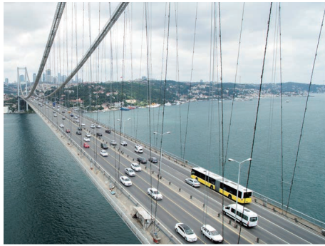
第 12 図 斜めハンガー撤去前と撤去後の状況 Fig. 12 Situation before and after dismantling inclined hanger
