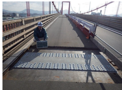
第 8 図 新連結板による鋼床版連続化の状況 Fig. 8 Orthotropic steel deck continuation situation by new connection plates
