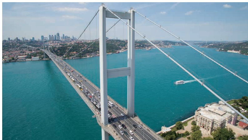
第 9 図 「第 1 ボスポラス橋」全景 Fig. 9 Panoramic view of "Bosphorus Bridge"
