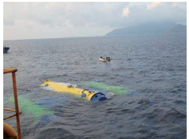
口之島沖での設置作業の様子
