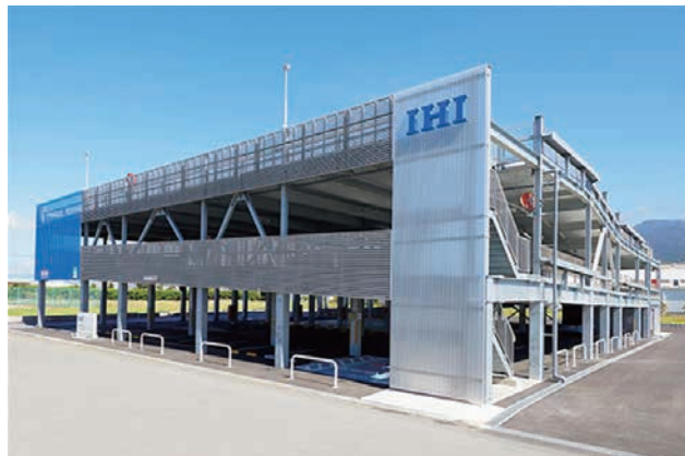
自走式立体駐車場
