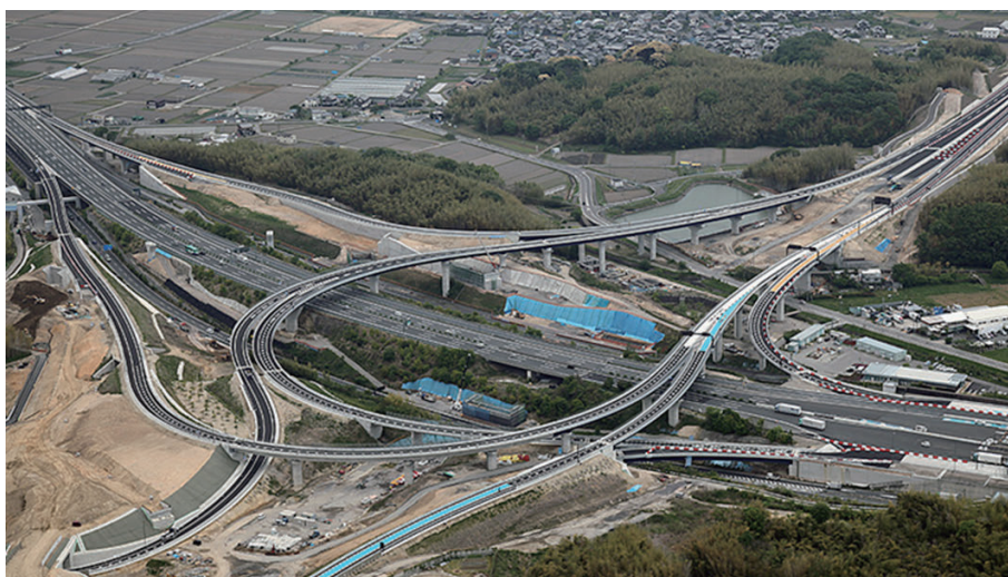
第 3 図 八幡ジャンクション全景 Fig. 3 General view of Yawata Junction
