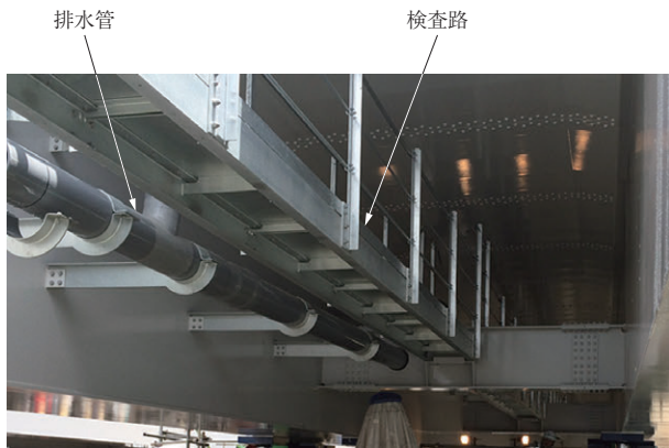
第 11 図 検査路と排水管の設置状況 Fig. 11 Inspection platform and drainpipe
