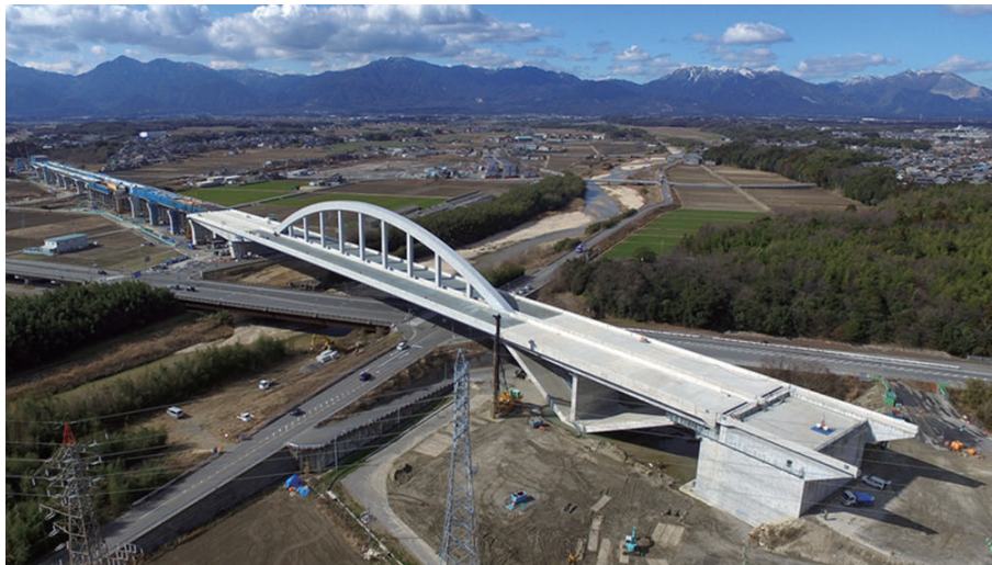
第 1 図 「朝明川橋」全景 Fig. 1 General view of "Asakegawa Bridge"
