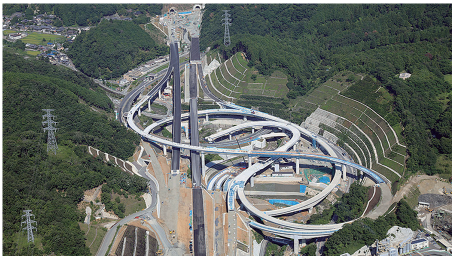
第 12 図 箕面とどろみインターチェンジ（「余野川橋」含む）全景 Fig. 12 General view of Minoh-Todoromi Interchange and “Yonogawa Bridge”
