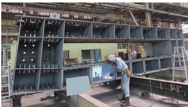
第 7 図 接合部 工場製作状況 Fig. 7 Fabrication of steel/PC composite bridge connection
