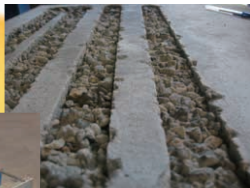
コンクリートはつり
