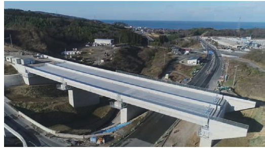
第 25 図 多伎 PC 上部工事の完成 (2) Fig. 25 Photo of completion of construction Taki PC upper bridge (2)
