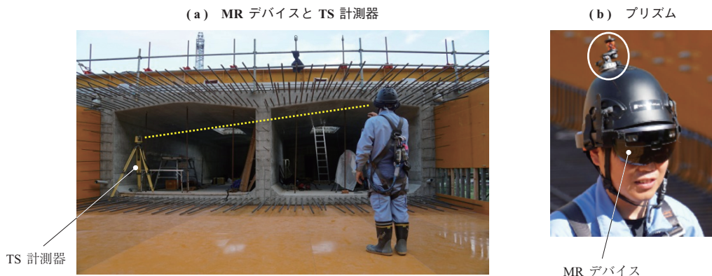
第 21 図 MR と TS の連携による計測 Fig. 21 Measurement using MR-TS integration
