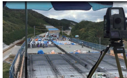
第 15 図 TS による床版品質管理 (2),(3) Fig. 15 Floor slab quality control using TS (2),(3)
