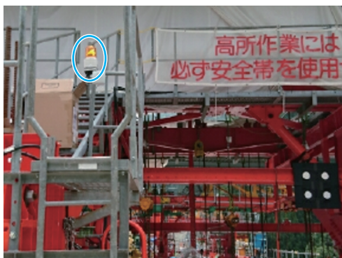
(a) 作業中の移動監視用パトライト
