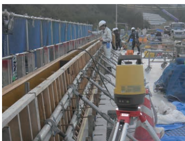
(a) 壁高欄型枠 TS 測量
