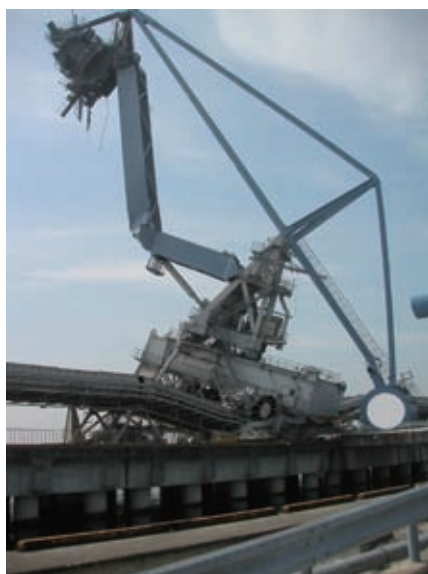
第 3 図 アンローダ 3 号機の被災状況 Fig. 3 Damage to the No.3 unloader
