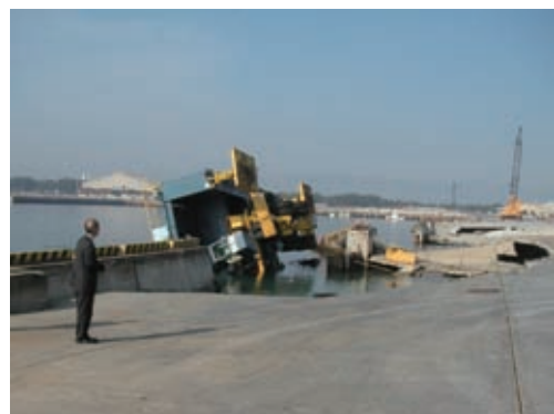
第1図 相馬港2号埠頭の岸壁被災箇所とクレーン Fig. 1 View of damage at the No. 2 wharf in Soma Port
