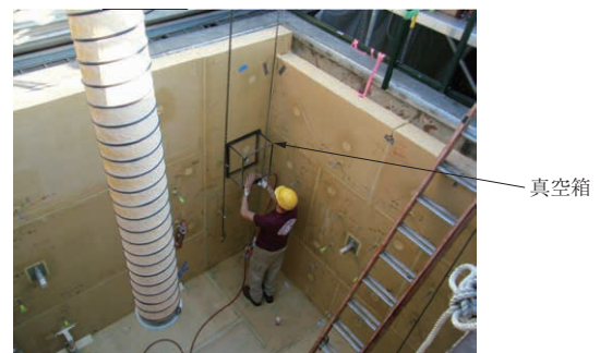
第7図 セカンダリバリアの真空試験状況 Fig. 7 Vacuum box test applied to the secondary barrier system
