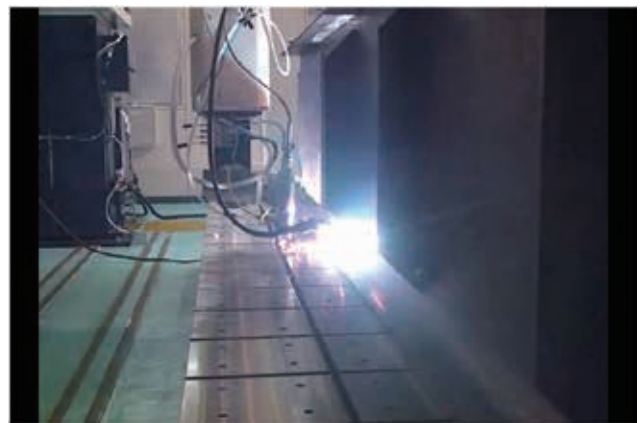
レーザー・アークハイブリッド溶接施工状況
