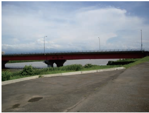
第 9 図 測定対象橋梁 C の外観 Fig. 9 External view of bridge C
