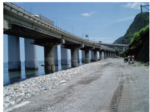
第8図 測定対象橋梁 B の外観
