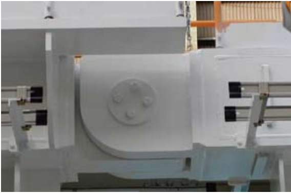
第 14 図 大和川線シールド 後方作業台 ジョイント部 Fig. 14 Joint of back work place of Yamatogawa line shield
