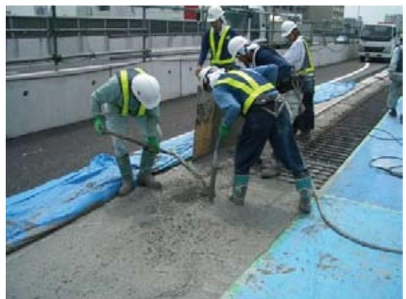
第 24 図 床版間詰め部への打込みと締め固め
