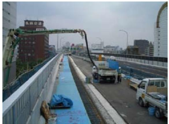
第 23 図 小型ダンプ車による荷受けと運搬
