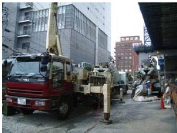
第 22 図 コンクリートポンプ車による圧送
