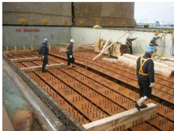
第 13 図 ハッチ内積み込み状況 Fig. 13 Loading on a hatch
