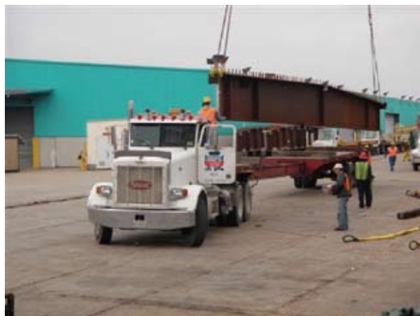
第 14 図 現地陸上輸送 Fig. 14 Road transport to the site
