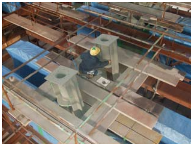
第 11 図 鋼桁アンカー定着部の塗装状況 Fig. 11 Coating applied to a fixing part of steel girder anchor
