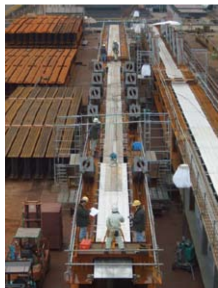
第 10 図 鋼桁の仮組検査状況 Fig. 10 Trial assembly of steel girders
