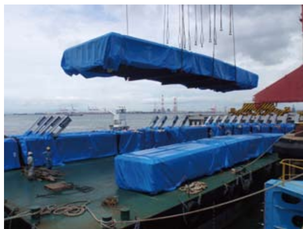
第 12 図 台船への積み込み状況 Fig. 12 Loading onto barge
