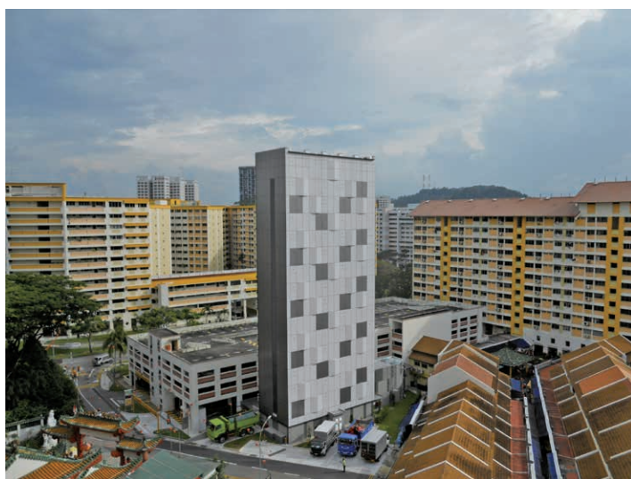
シンガポール政府の住宅開発庁向けエレベータパーキング
