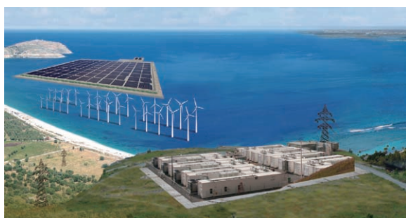
第 8 図 リチウムイオン電池による太陽光・風力発電安定化システム Fig. 8 Lithium ion battery system to supplement inconsistent sources of energy such as solar and wind power
