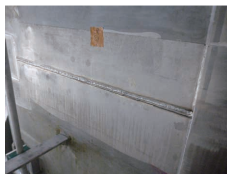
鶴田ダム不動態処理施工状況
