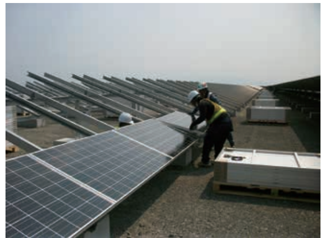
パネル取付状況
