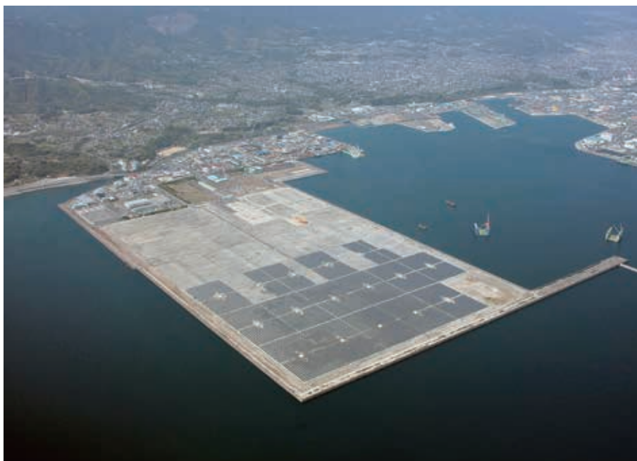
鹿児島七ツ島メガソーラー発電所（平成 25 年 3 月撮影）
