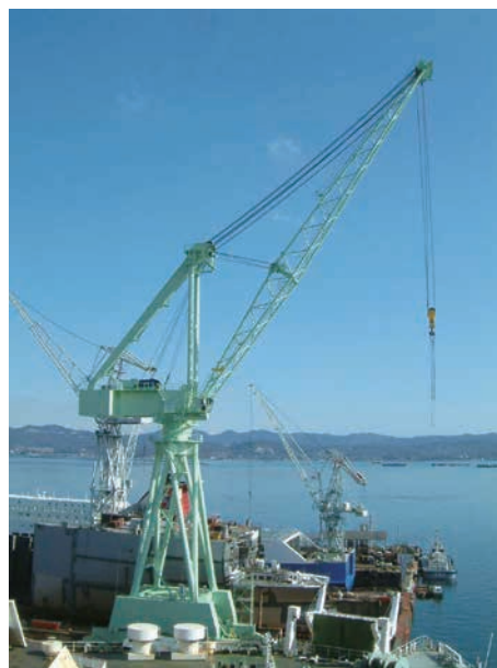
第2図 ジブクレーン Fig. 2 Jib crane
