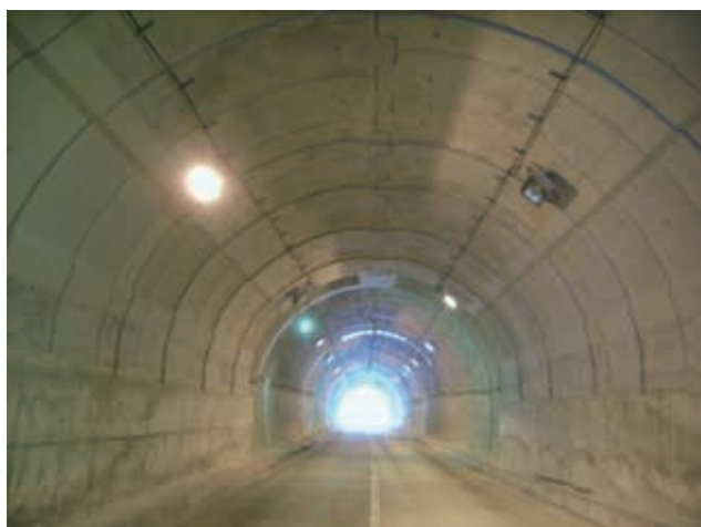
部分薄肉化 PCL 施工
