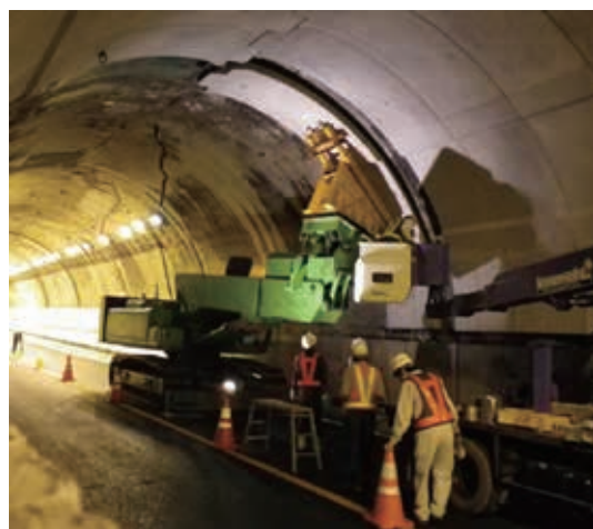
部分薄肉化 PCL 架設状況
