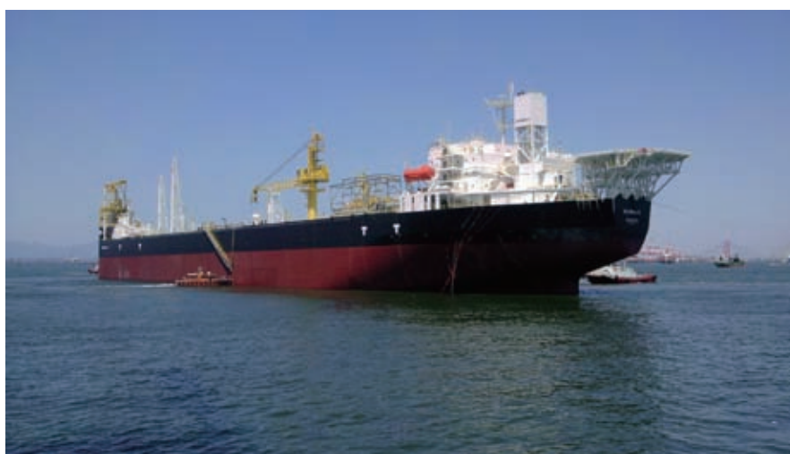
浮体式石油貯蔵積出設備「ERAWAN 2」
