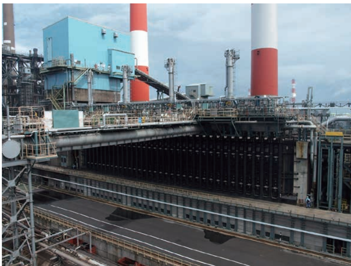
新日鐵住金株式会社鹿島製鐵所のコークス炉増設 (写真提供：新日鐵住金株式会社)
