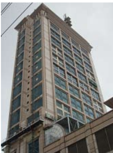
(a) ビルの外観
