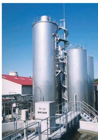
工場の有機性排水を効率良く処理し、エネルギーを取り出せます
