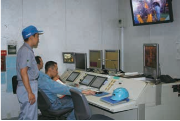
エンジン試運転制御室
