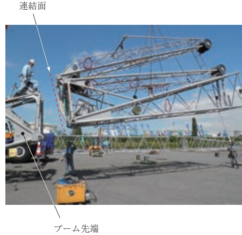
第 10 図 ジブ起伏装置ユニットの現地搬入からブーム接続まで Fig. 10 From transportation to connection of jib hoist unit
