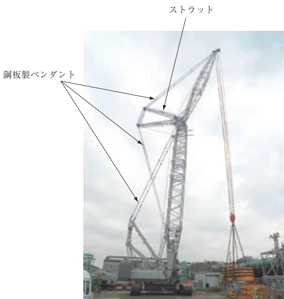
第 7 図 1 000 kN 超のウエイト吊り上げによる過負荷試験 Fig. 7 Overload test
