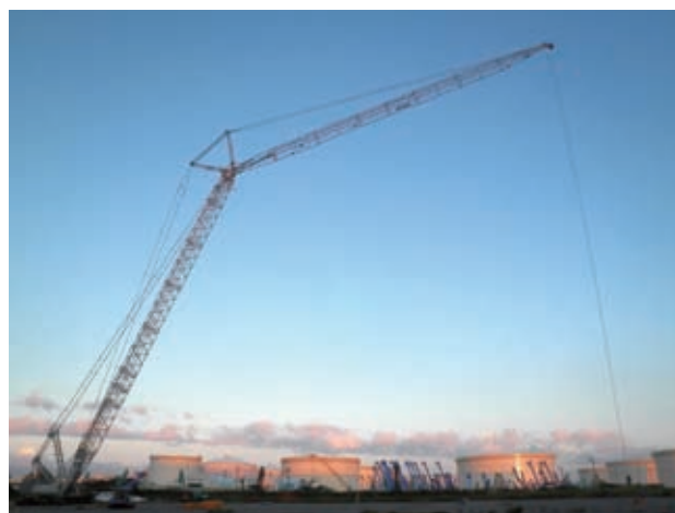
第 1 図 ラフィングジブ・クローラクレーン CCH3000LJ 最長構成 Fig. 1 Luffing jib crawler crane CCH3000LJ (Longest configuration)
