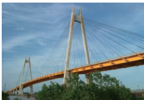
第1図 「 Binh 橋 」全景
