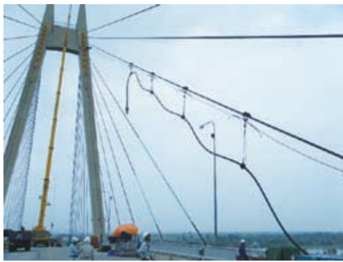
第 22 図 ケーブル撤去時の様子 Fig. 22 Removal of stay cable
