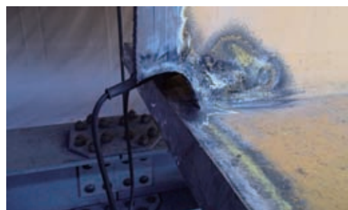
第 17 図 開先加工 Fig. 17 Grooved weld edge
