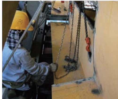
第 16 図 桁切断 Fig. 16 Cutting of main girder
