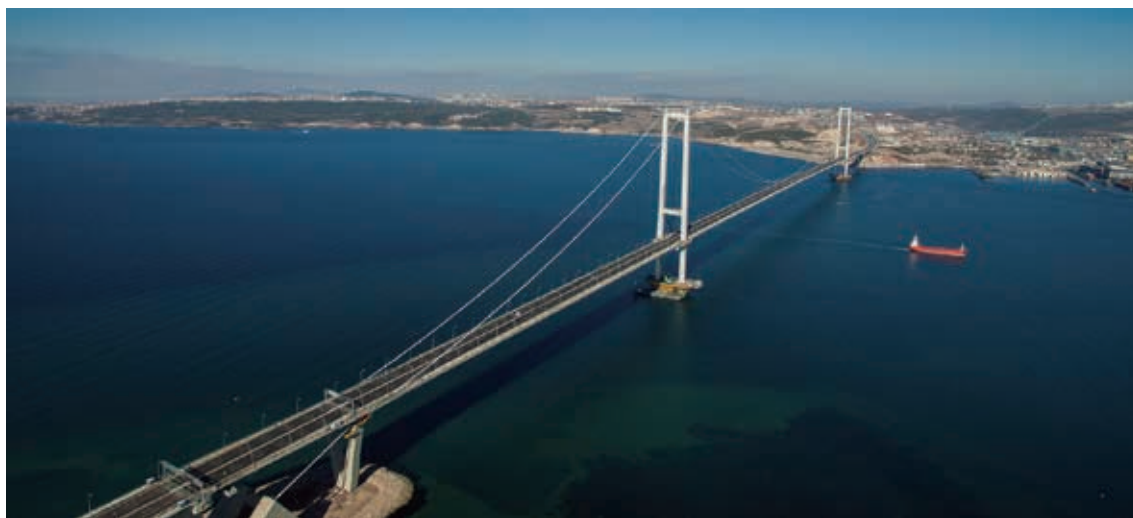
オスマン・ガーズィー橋（イズミット湾横断橋）完成写真
