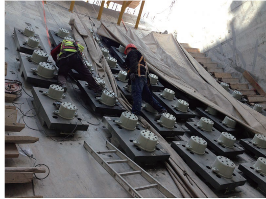
第 17 図 クロスヘッドスラブおよびアンカーキャップ Fig. 17 Cross head slab and anchor cap
