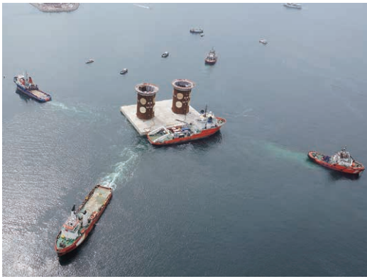
第 10 図 ケーソンの沈設作業の様子 Fig. 10 A look at the caisson sinking operation
