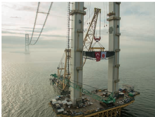
第 32 図 補剛桁架設 Fig. 32 Deck erection
