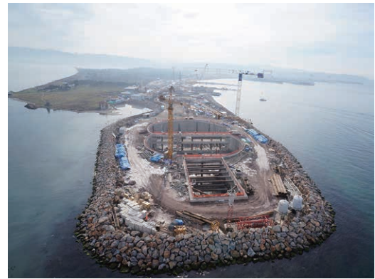
第 16 図 南側アンカレッジの地中連続壁およびコンクリート打設状況 Fig. 16 Diaphragm wall and mass concreting for south anchorage
