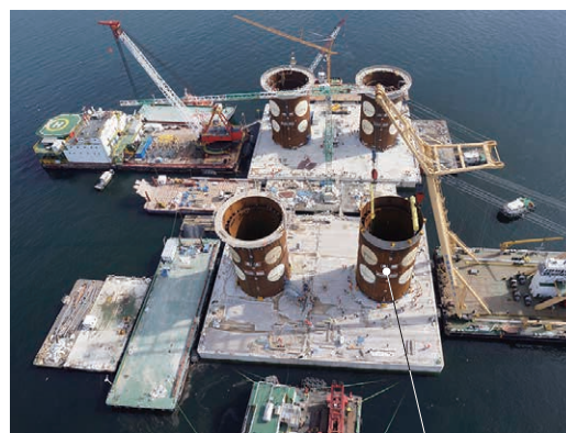
第8図 ケーソンの曳航 Fig. 8 Caisson towing to the wet dock
