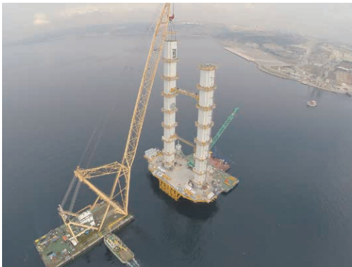
(a) FC によるブロック架設状況
