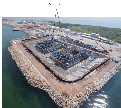
第7図 ドライドックでのケーソンの製作状況 Fig. 7 Caisson production at drydock
