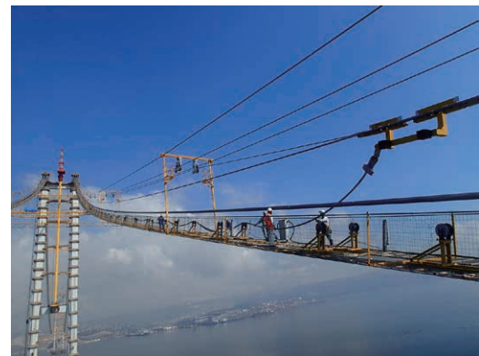
第 30 図 PPWS 引出し状況 Fig. 30 PPWS erection
