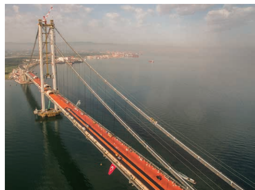
第 34 図 並行する各種橋面工 Fig. 34 Surfacing work on bridge in parallel
