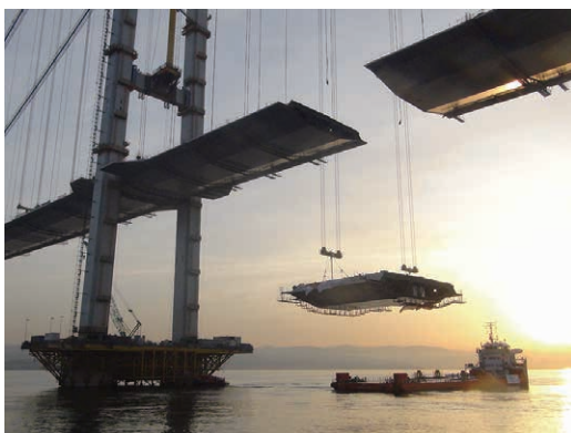
第 33 図 南側径間での補剛桁閉合 Fig. 33 Deck closure at south side span
