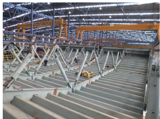
第 22 図 屋内連続組立 Fig. 22 Block assembly of deck
