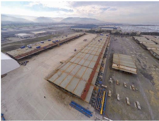
第 23 図 屋外連続仮組 Fig. 23 Trial assembly of deck
