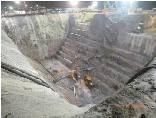
第 13 図 北側アンカレッジ掘削状況 Fig. 13 Rock excavation for north anchorage
