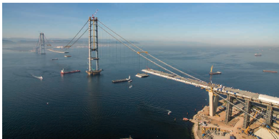
第 1 図 「イズミット湾横断橋」補剛桁ブロックの各スパン同時架設状況 Fig. 1 Fast construction for deck of “Izmit Bay Bridge”
