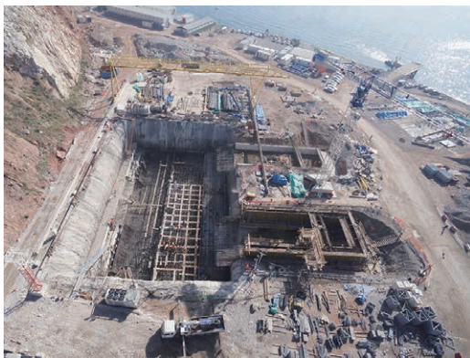
第 14 図 北側アンカレッジのコンクリート打設状況 Fig. 14 Concrete casting for massive part for north anchorage
