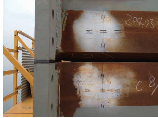
第 26 図 マッチングピースおよび調整用シム Fig. 26 Matching piece and shim plates for geometry control
