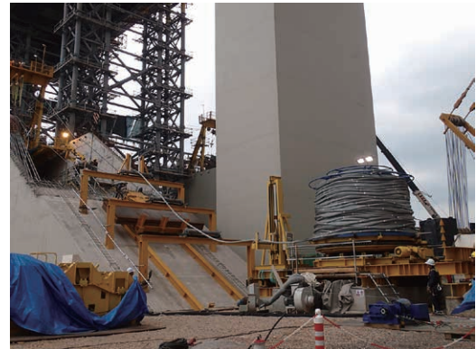
第 29 図 PPWS 引出し設備 Fig. 29 PPWS unreeler
