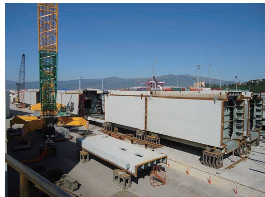
第 20 図 主塔の水平仮組 Fig. 20 Trial assembly of tower
