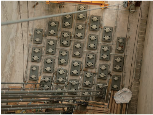
第 17 図 クロスヘッドスラブおよびアンカーキャップ Fig. 17 Cross head slab and anchor cap
