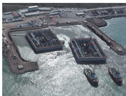
第8図 ケーソンの曳航 Fig. 8 Caisson towing to the wet dock
