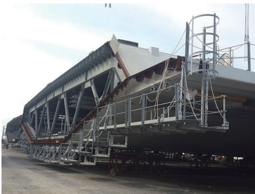
第 24 図 吊り足場の設置 Fig. 24 Installation of scaffolding
