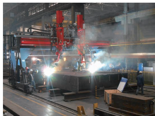
第 19 図 主塔パネル製作状況 Fig. 19 Tower panel fabrication
