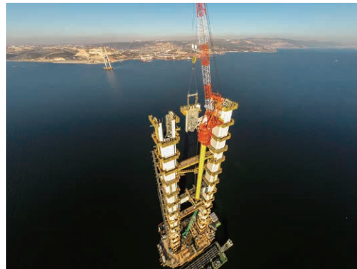
(b) JCC によるパネル架設状況
