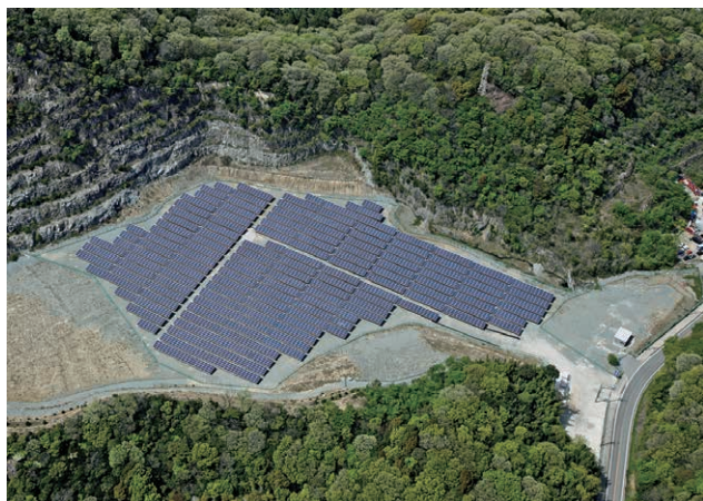
太陽光発電設備の設置に当たり、トータルでお客さまをサポートします
