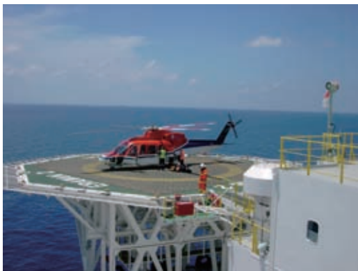
第 2 図 ヘリデッキ Fig. 2 Helicopter deck
