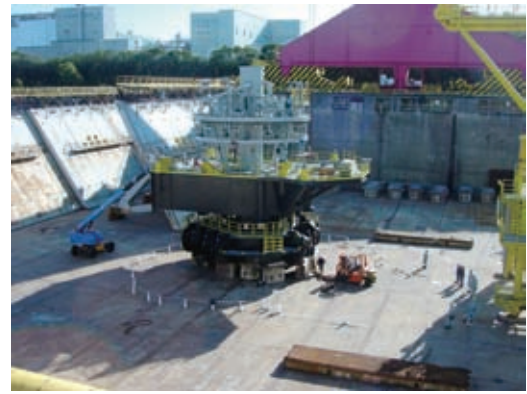
第 3 図 搭載前のエクスターナルターレット Fig. 3 External turret at dock
