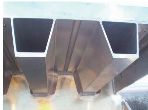
第 3 図 「小高川橋」側道橋の拡幅工事（アルミ製歩道用床版） Fig. 3 “Odakagawa Bridge” — Side road
