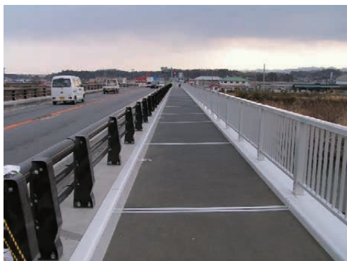
第 3 図 「小高川橋」側道橋の拡幅工事（アルミ製歩道用床版） Fig. 3 “Odakagawa Bridge” — Side road
