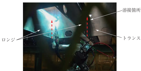
第 7 図 枠組みロボット溶接 Fig. 7 Framework robot welding
