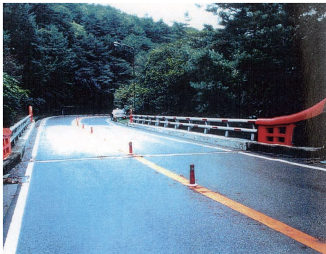
第1図 「金慶橋」（アルミ製道路橋） Fig. 1 “Kinkei Bridge”
