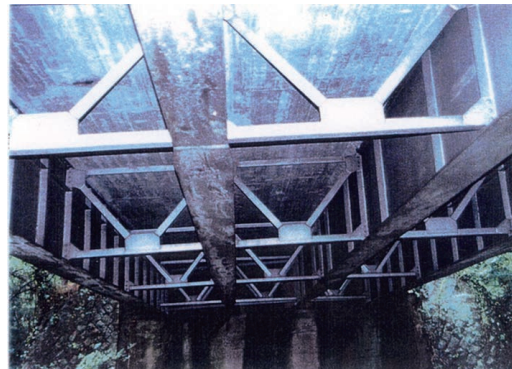
第1図 「金慶橋」（アルミ製道路橋） Fig. 1 “Kinkei Bridge”
