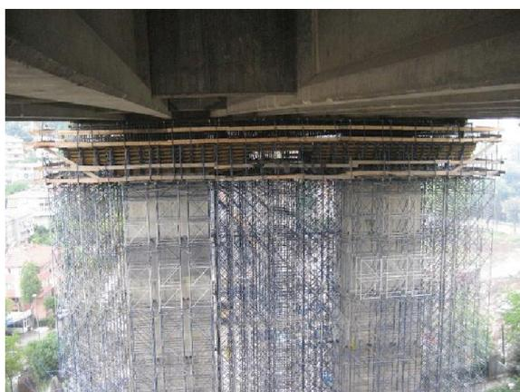
第 14 図 新設 PC 横梁の型枠設置状況
