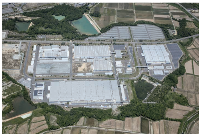
相馬工場全景（空撮） （太陽電池は敷地内の 4 か所に設置されている）
