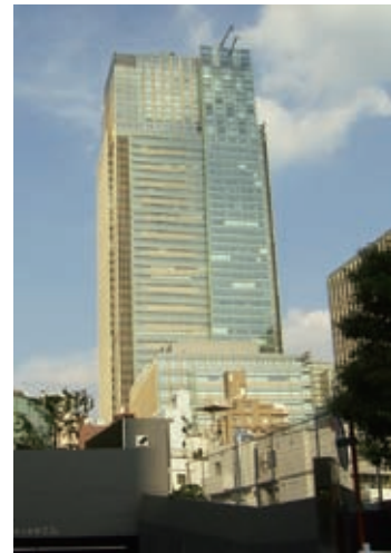
第4図 東京ミッドタウンタワー Fig. 4 Tokyo Midtown Tower
