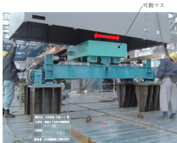
第3図 銀座三井ビルディングと制振装置の外観 Fig. 3 Ginza Mitsui Building and mass damper
