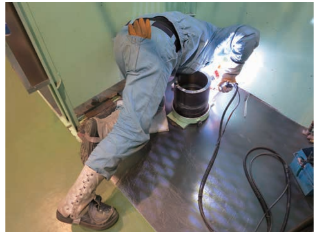
狭隘部での溶接資格訓練
