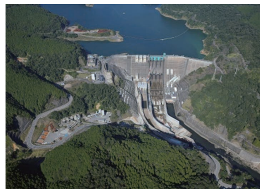
第 3 図 鶴田ダム全景 Fig. 3 Panoramic view of Tsuruda dam
