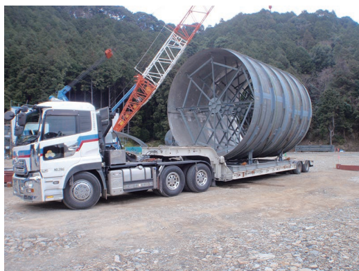
第4図 増設放流管の輸送状況 Fig. 4 Transportation of the additional discharge pipe
