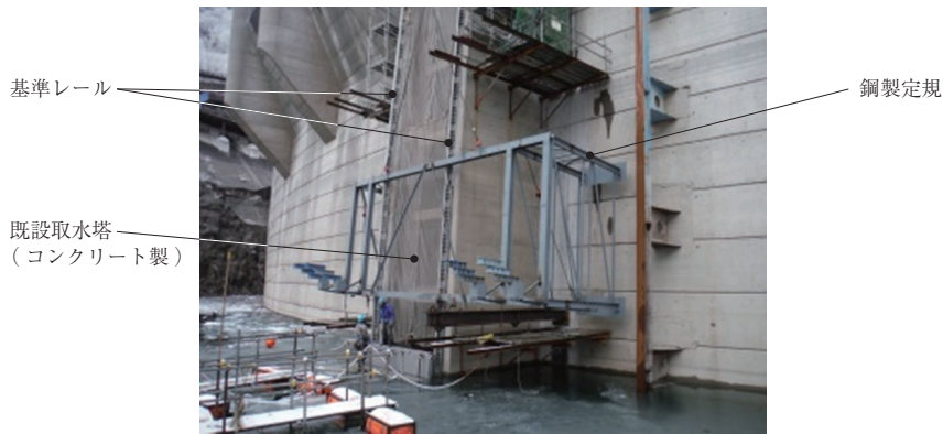
第 9 図 基準レールを利用したダム堤体の測量 Fig. 9 Survey using the reference rail
