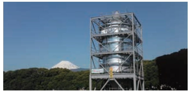
試験用石炭貯蔵設備（IUK 沼津工場）
