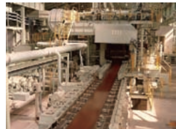
(b) 設備の外観
