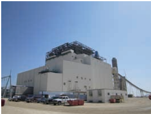
第2図 Sandy Creek 発電所向けボイラ全景 Fig. 2 Sandy Creek Energy Station
