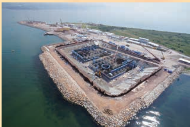
南側建設現場（手前はケーソン製作中のドライドック）
