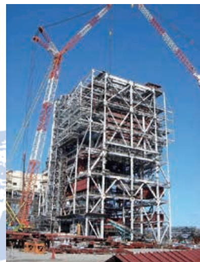
ボイラ建設現場
