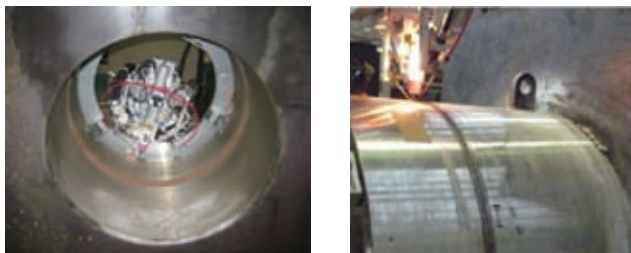
第10図 異材配管継手による確性試験状況 Fig. 10 Situation of dissimilar joint welding
