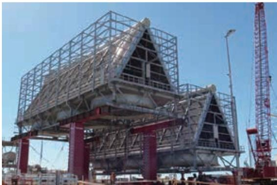
巨大な空冷復水器モジュールを現地にジャッキアップしている様子
