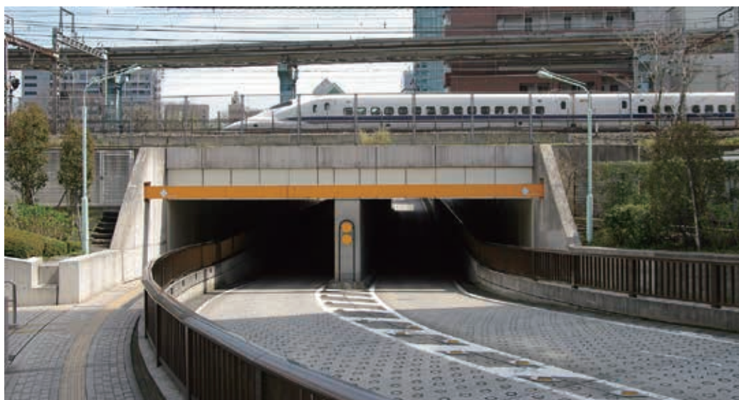
URT 工法で構築した鉄道／道路の立体交差
