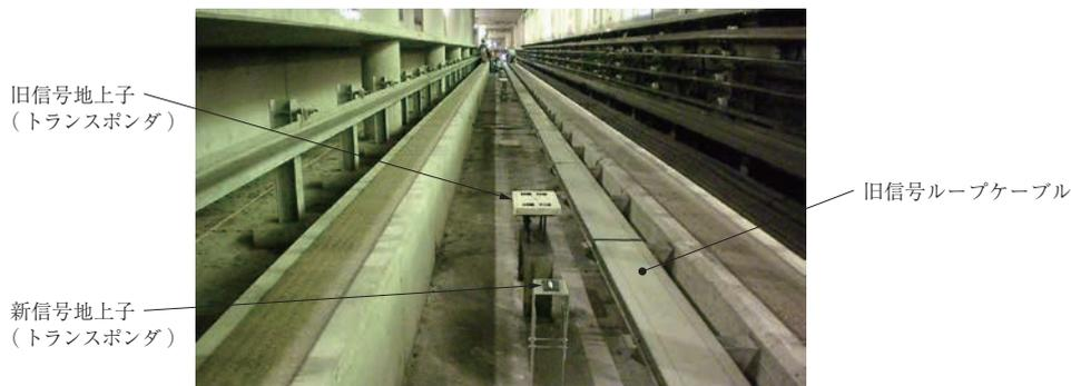
第 2 図 走行路の中に設置された新旧信号システム地上側機器、地上子
