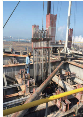
第 12 図 試験伝熱面の吊込み状況 (9) Fig. 12 Installation of a 700°C A-USC verification test loop (9)
