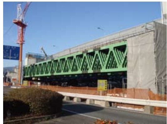
コンクリート橋支保工
