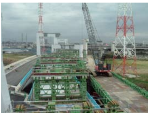
工事中栈橋（200トンクレーン作業用）
