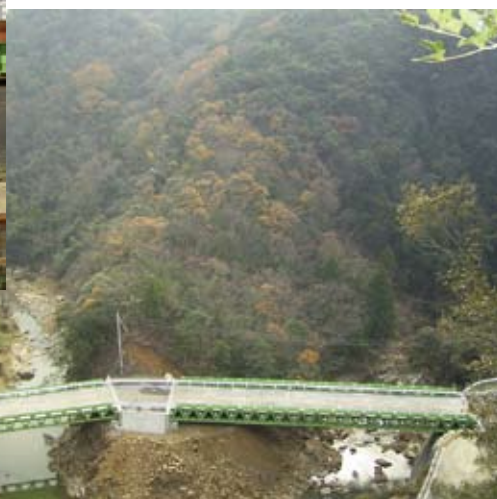
災害復旧トラスタイプ迂回路橋
