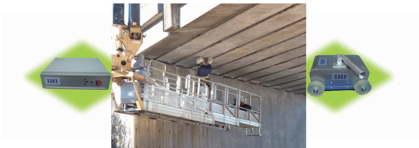
「コンクリートビュー」による測定の様子
