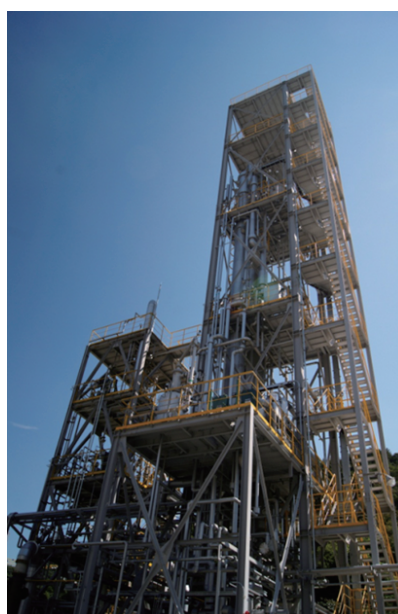
第 6 図 20 t-CO 2 /d パイロットプラント Fig. 6 Photograph of the pilot plant
